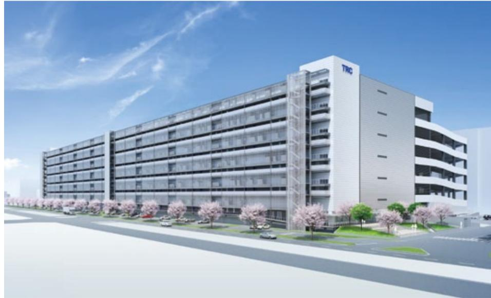
「1フロア数百坪から数千坪までのフレキシブルな賃貸面積対応」や「免震構造」等、新B棟の特徴は様々ありますが、例えば「歩廊」の存在が象徴的です。物流施設につきものの「車両」、TRCの物流施設につきものの「人」。この相容れない二つの要素の共存を実現させるため、各階の建物外周部に約3kmに亘る「歩廊」を設置します。行き交う人々の安全性確保だけでなく、バス・車路での物流活動の効率化も見据えたものです。
