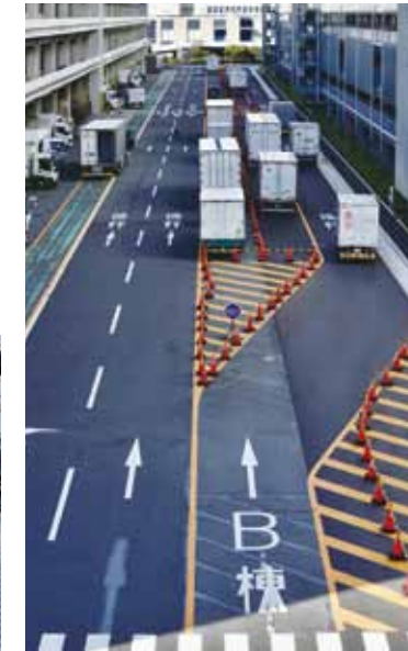
物流ビルA・B棟間 南から北へ的一方通行
